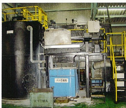
①撤去した排水処理設備
