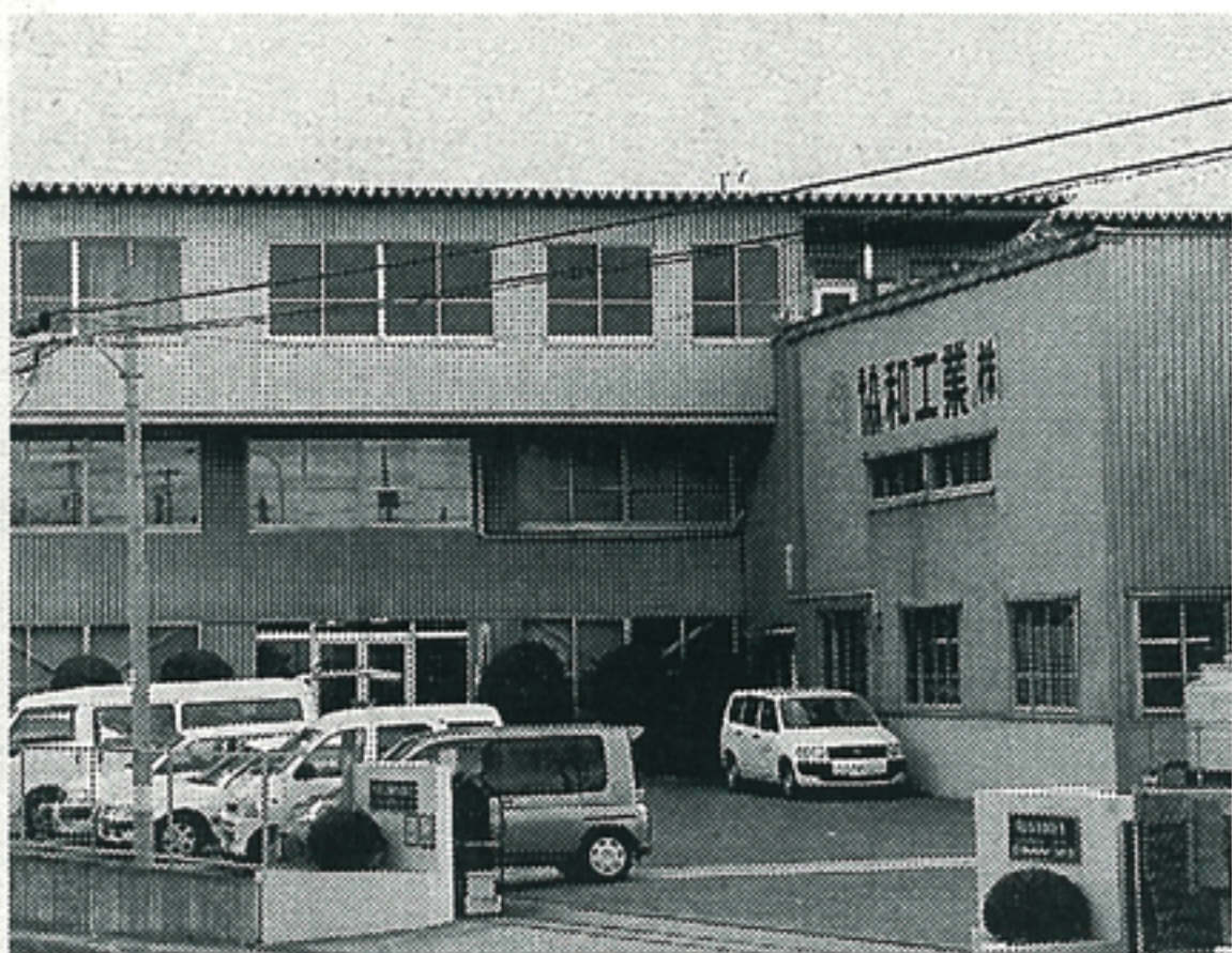
新工場を建設する協和工業本社（大府市横根町坊主山）
